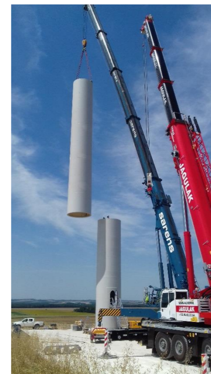
Figure 71 : Montage de la seconde section du mât (Source : VOLKSWIND)
