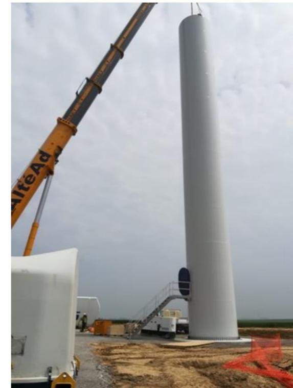
Figure 70 : Montage de la première section du mât (Source : VOLKSWIND)
