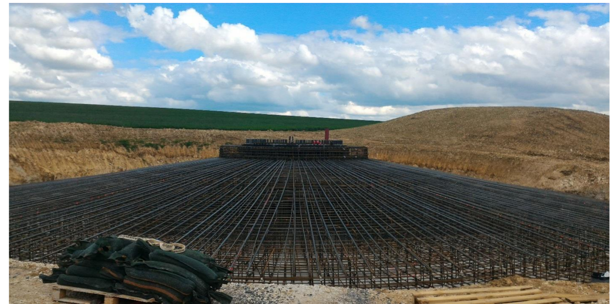
Figure 64 : Ferrailage du massif (Source : VOLKSWIND)
