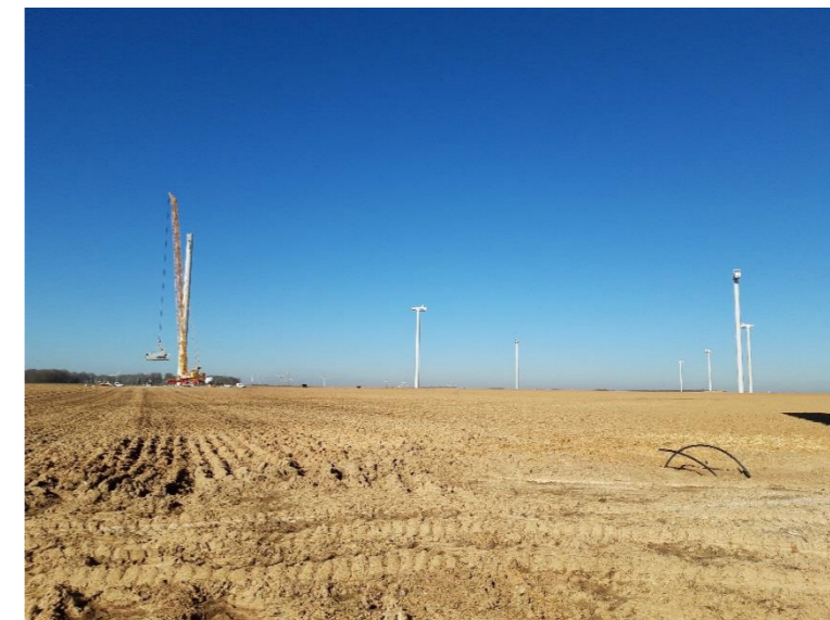
Figure 75 : Un parc de neuf éoliennes Vestas V112 en construction (Source : VOLKSWIND)
