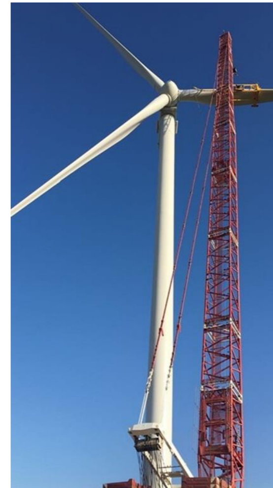
Figure 74 : Montage des pales (Source : VOLKSWIND)
