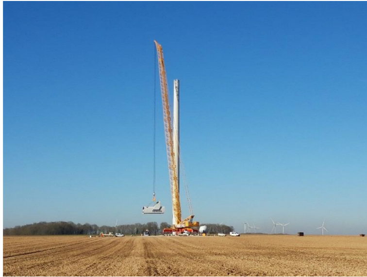
Figure 72 : Montage de la nacelle (Source : VOLKSWIND)
